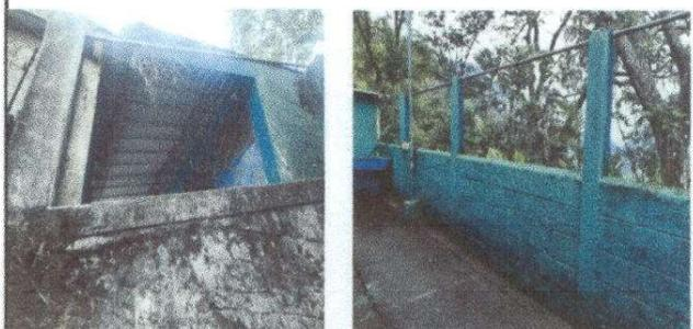
Foto 6: Malla dañada, se quiere sustituir por balcones de metal ( largo 27.50mts y alto 11 mts)
